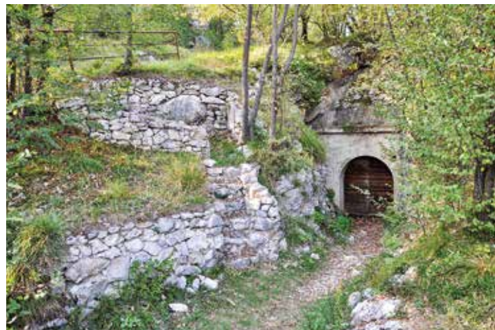
L'ingresso della batteria in caverna nella zona del Pontesel
